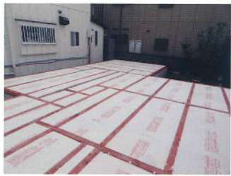
床下のウレタン断熱材
