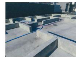
鉄筋コンクリートベタ基礎
