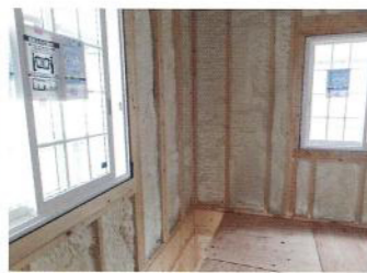
より高い断熱性を実現する現場発泡ウレタン断熱
